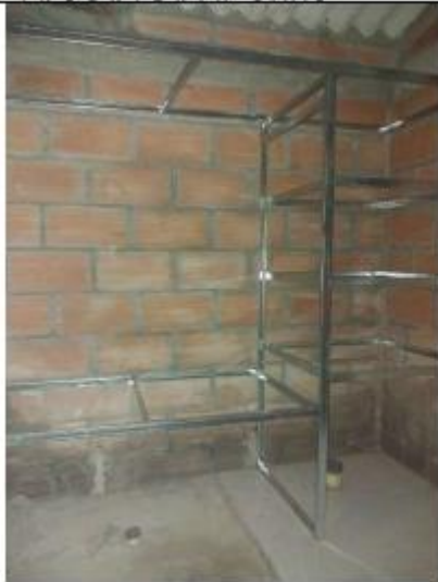
ARMADO ESTRUCTURA EN CLOSET
