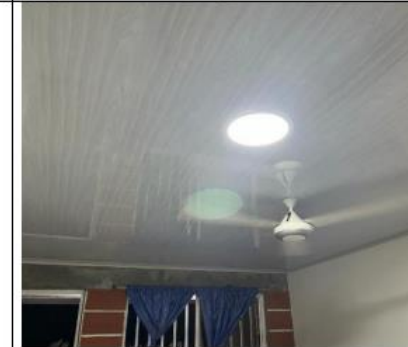
CLOSET TERMINADO EN DRIWALL
